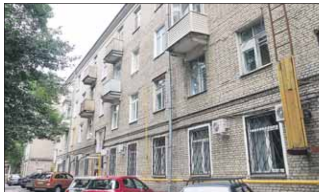
Депутаты будут контролировать ход работ по выборочному капитальному ремонту: в доме 4, корпус 3, на 3-м проезде Марьиной Рощи намечено отремонтировать балконы
