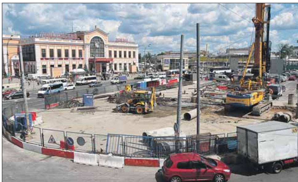
Из-за строительства метро автобусным остановкам пришлось потесниться
