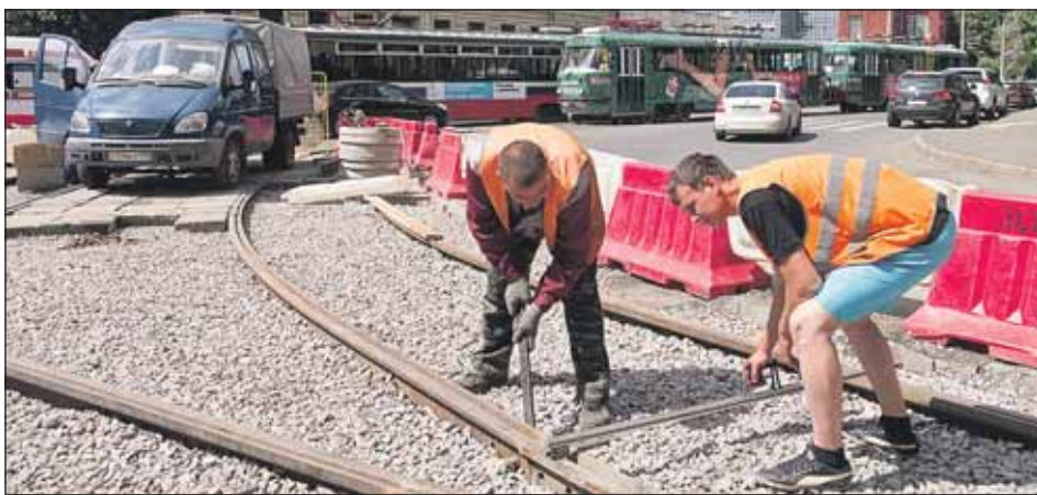
Работы по укладке трамвайной линии на пересечении улиц Образцова и Трифоновской
