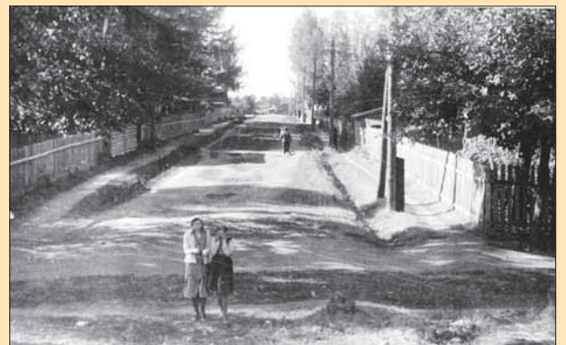
Позже, в конце 50-х, на эту булыжную мостовую положили асфальт. С тех пор дорога поднялась примерно на метр
